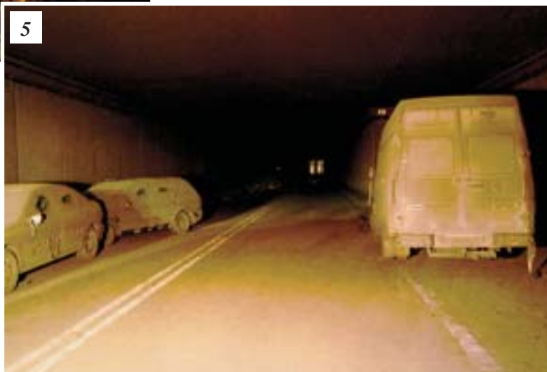
5 - Traforo del Gottardo. Automezzi ricoperti da uno spesso strato di cenere e nerofumo anche a distanza dall'incendio. Nel 2000 il traforo è stato attraversato da 18.000 veicoli al giorno (di cui 4500 pesanti) (Foto DPA).
